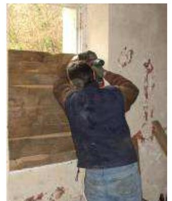
Toujours au rez-de-chaussée, dans la pièce côté est nous avons renforcé la porte et fermé partiellement la fenêtre côté jardin. Cette pièce, soumise aux courants d'air devrait avoir une amplitude thermique importante.
