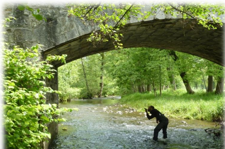
Contrôle de pont post-travaux
