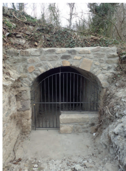
Grille installée au niveau de la cave pour sécuriser le site
