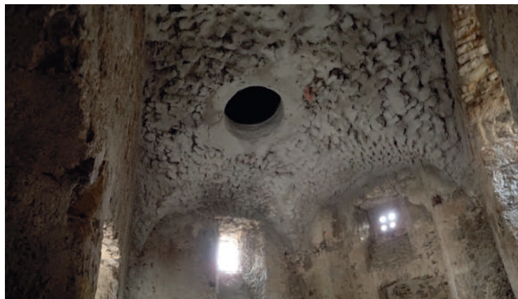
Voûte du pigeonnier après la réhabilitation
