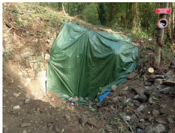
Bâche obstruant l'entrée de la cave
