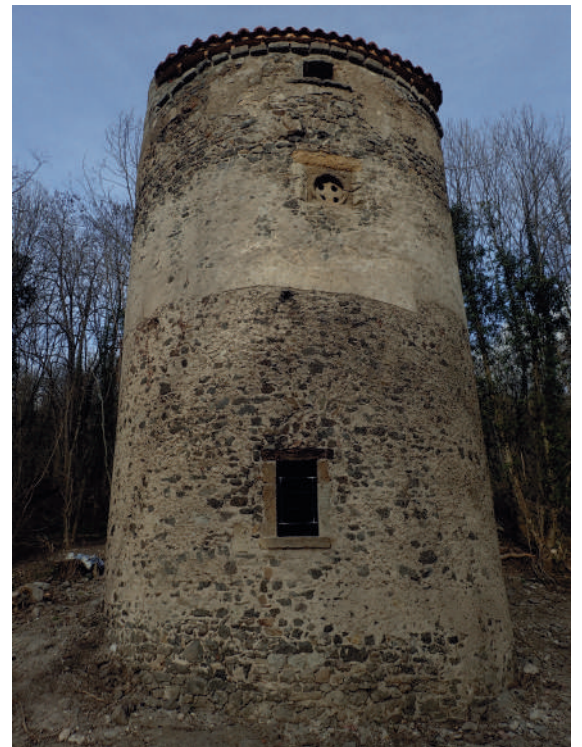
Pigeonnier après la réhabilitation
